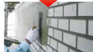
既存タイルの上にNPカチオンを塗り、新規のモルタル下地を作製。
